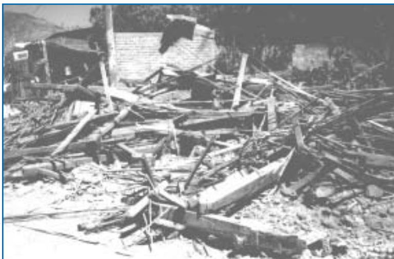
Bloqueo de vías por escombros.
