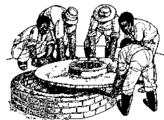
Ponga la losa curada en su lugar.
