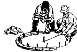
Haga un molde para la losa.
